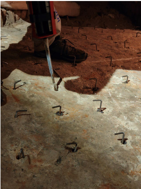
Documentazione fotografica inserimento perni e fissaggio con resina epossidica
