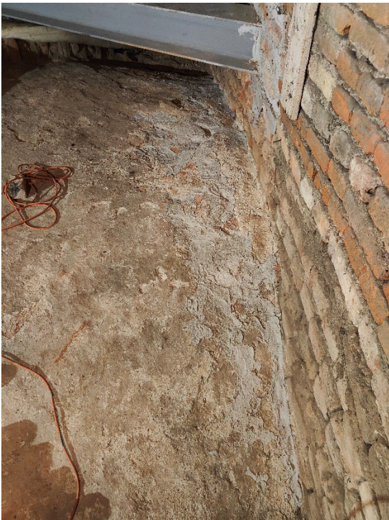
Documentazione fotografica riempimento fessurazione tessuto murario
