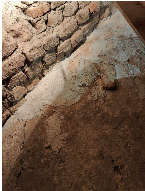
Documentazione fotografica riempimento fessurazione tessuto murario
