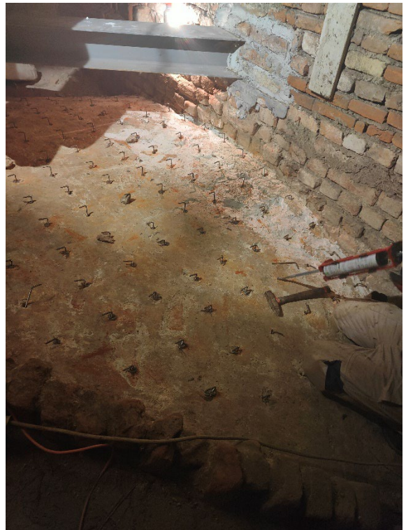
Documentazione fotografica inserimento perni e fissaggio con resina epossidica
