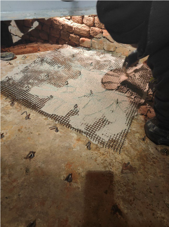
Documentazione fotografica rinforzo porzione centrale avvallamento
