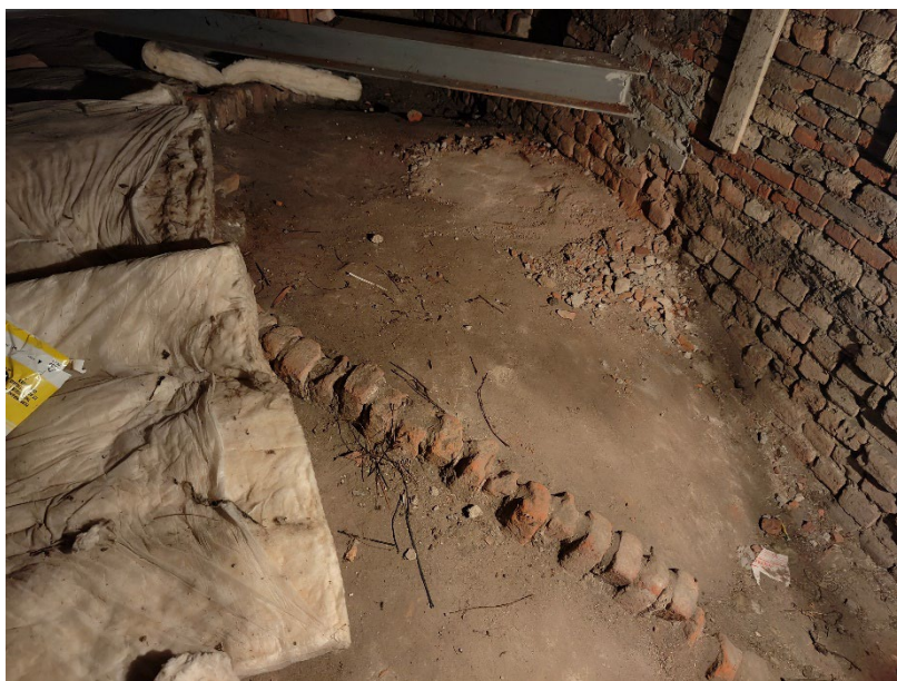
Documentazione fotografica area di intervento estradosso della volta
