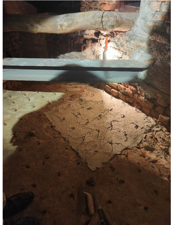
Documentazione fotografica rinforzo porzione centrale avvallamento
